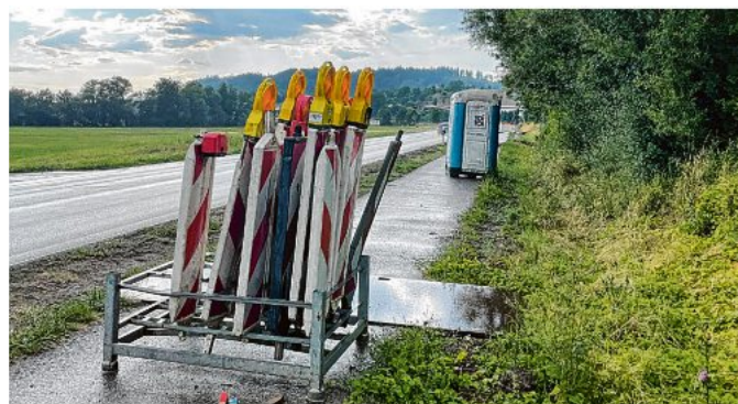
Entlang des Radwegs zwischen Unterrot und Mittelrot werden Gasrohre verlegt. Allerdings ruht die Baustelle seit einigen Wochen. Die Hindernisse sollen nun beiseite geräumt werden. Foto: Richard Färber
